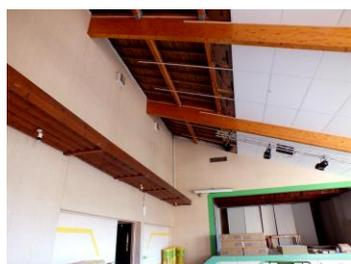
effectue les travaux d'isolation et de réfection du plafond de la grande salle et des parties annexes. Cette opération permettra de diminuer la consommation de chauffage et d'améliorer l'esthétique.
